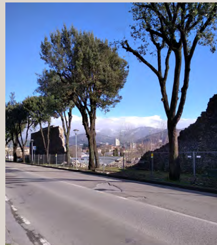
Pistoia, le Mura urbane crollate sul viale Arcadia
